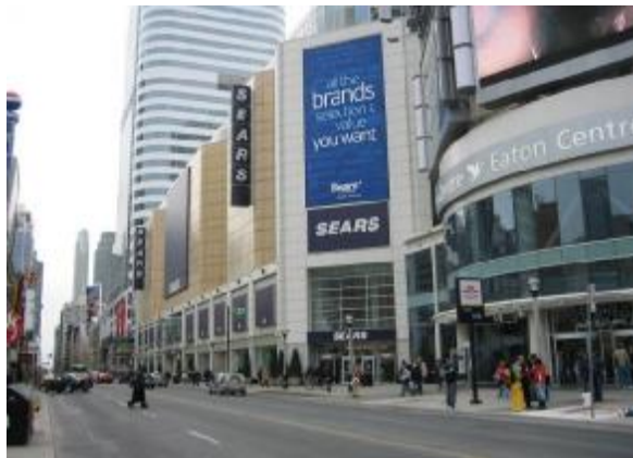
شکل (41) - فروشگاه زنجیره ای اتن در خیابان یانگ که در سال 1900 تونل زیر زمینی جهت اتصال به شعبه دیگرش در خیابان آنیکس ۲ احداث نمود.
