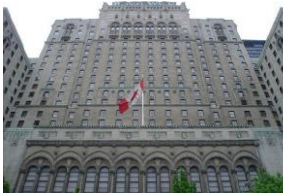
شکل (42) - ساختمان رویال یورک که توسط شاخه های اولیه مجموعه زیر زمینی پت در سال 1927 به ایستگاه یونیون متصل شد.
