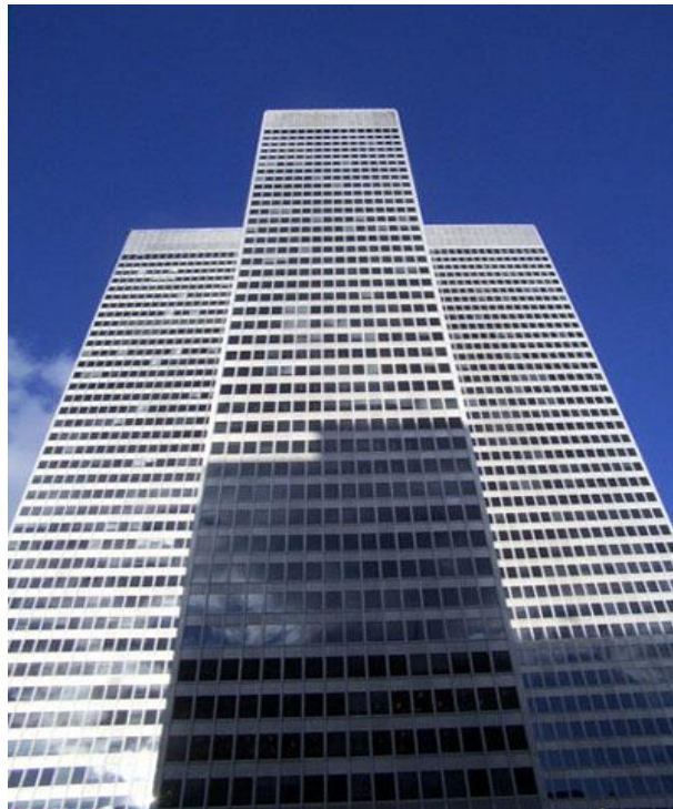
شکل (29) - ساختمان Palce Ville Marie که همراه با مال تجاری در شبکه زیر سطحی در سال 1962 ایجاد شد.
