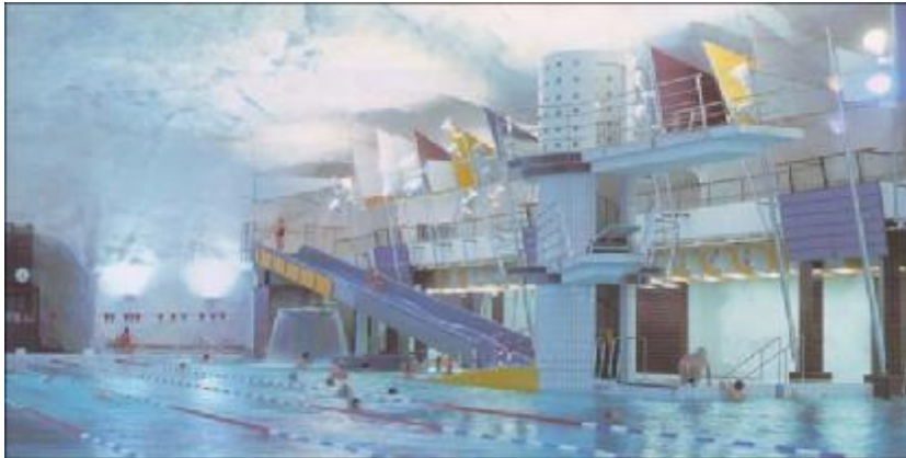
شکل (54) - استخر زیر سطحی در Itäkesku، فضای اصلی در دو طبقه گنجایش 1000 نفر تماشاچی در یک زمان و حدود 400000 بازدید کننده در سال را دارا است. این فضا که در میان صخره ها احداث شده می تواند در مواقع اضطراری سرپناه 3800 نفر باشد.
